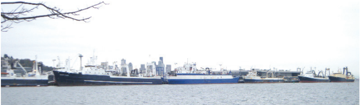
図Ⅶ.3-1 Pier 90, 91 は、大型漁船(ファクトリートローラー)のシアトルにおける停泊港であり、夏季はクルーズ船ターミナルとして利用
