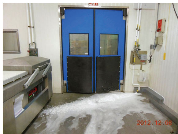
図Ⅶ.6-7 泡洗浄装置
