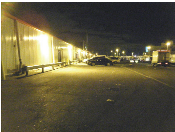
図Ⅶ.7-3 売場施設外壁（写真左側）
