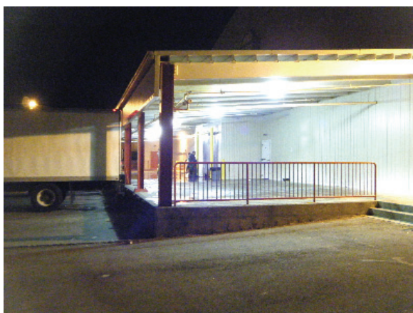
図Ⅶ.7-34 荷卸し用プラットホーム
