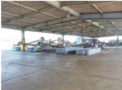
三重外湾漁業協同組合 荷捌き施設
