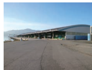
荷捌施設の外観
