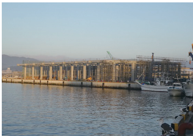
宮城県漁業協同組合志津川支所 建設中の新荷捌き施設外観
