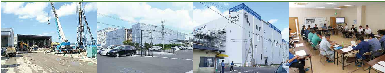
建設中の松浦魚市場荷捌き施設
