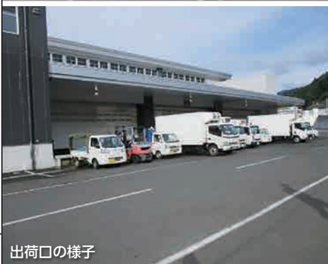
荷捌き施設外観
