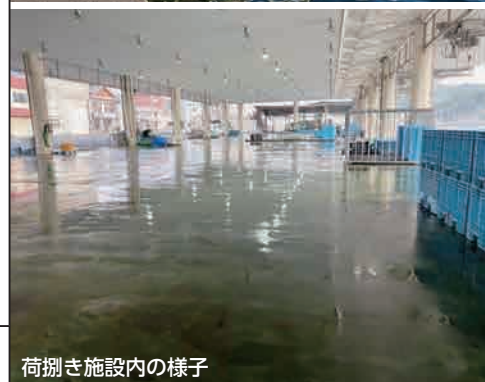
荷捌き施設外観
